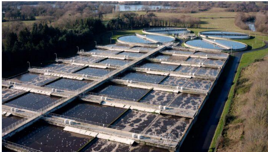
Station d'épuration de Rennes Métropole
